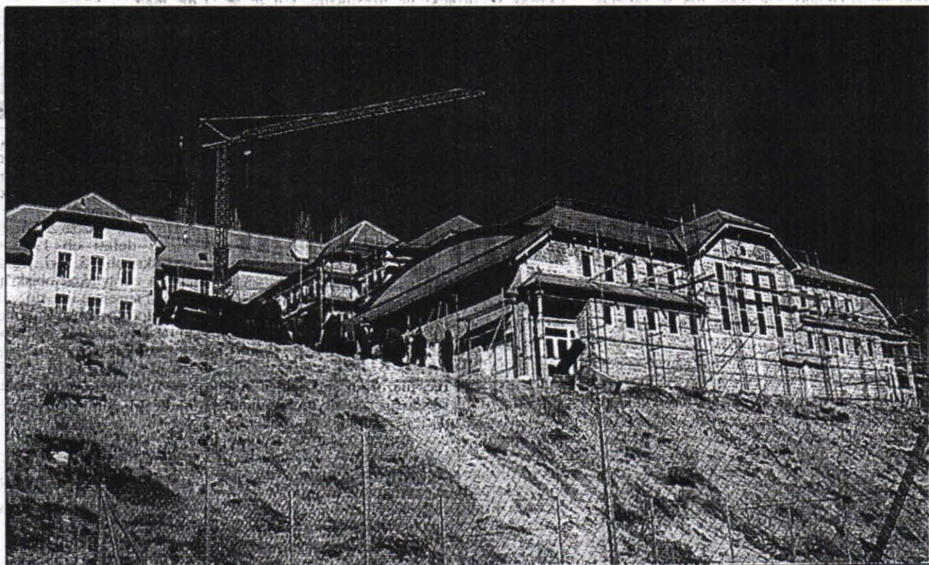
Pogled na gradbišče šolskega prizidka na Destrniku, ki naj bi že to jesen sprejel pod svojo streho mlade iz Slovenskih Goric. Posnetek: Tatjana Mohorko
